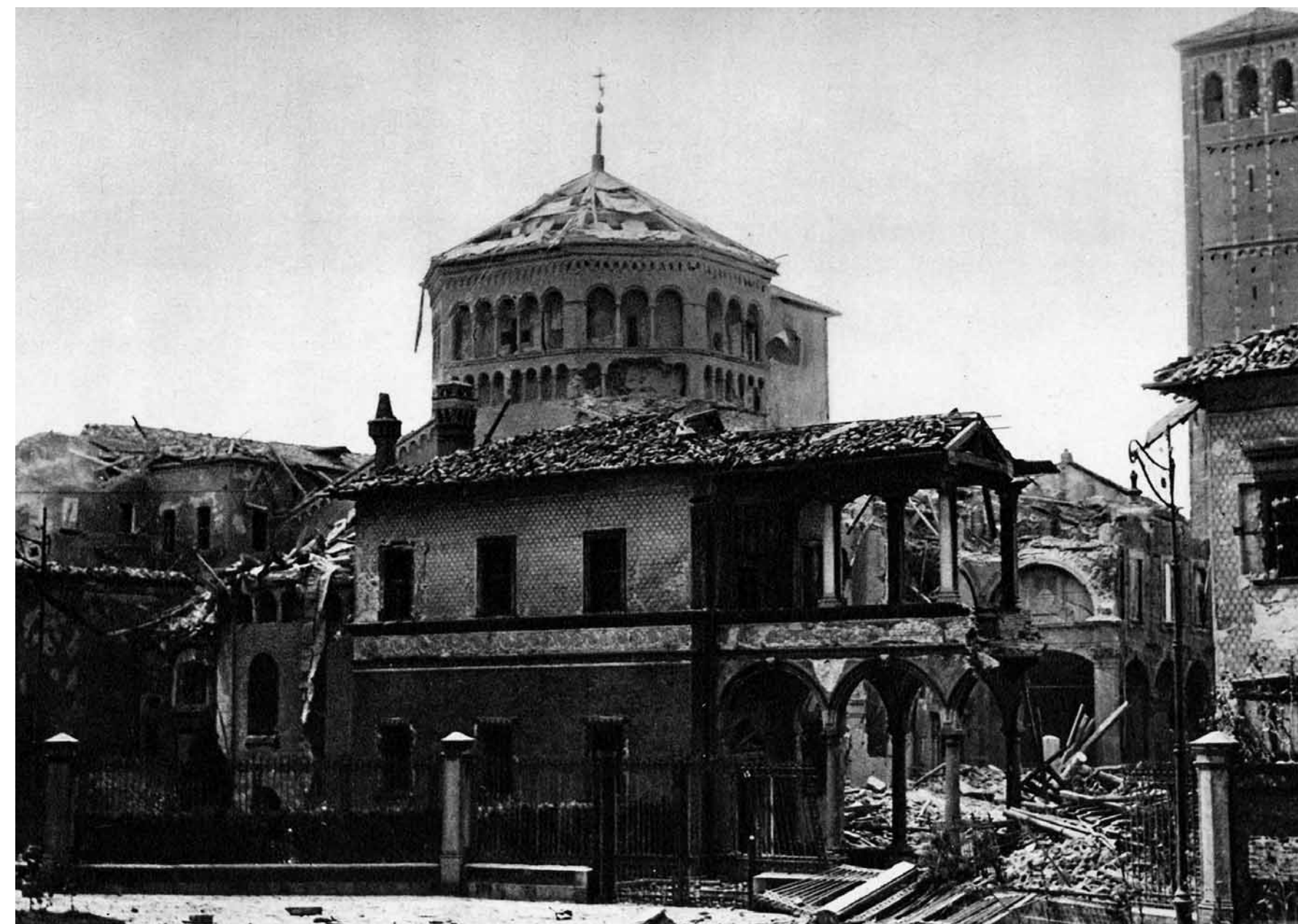
La basilica di Sant' Ambrogio devastata. - The Basilica St. Ambrogio destroyed.
