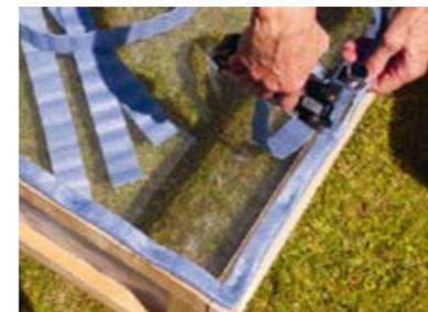
Se la copertura è da posizionare sopra un'aiuola rialzata, meglio dotarla di 'guarnizione' per chiudere eventuali fessure. Si usa qualunque materiale flessibile e durevole come feltro, rete o camera d'aria. Con la sparapunti fissare il materiale lungo il margine inferiore della base.
