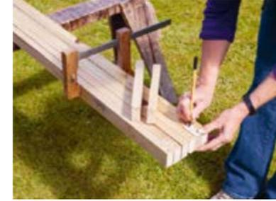
Usando la dima per marcare, fare i segni sulle estremità di tutte le assi da 366 cm e su tutte quelle da 117 cm. Fare una coppia di fori a 92 cm, 183 cm e 274 cm lungo un margine di tutte le assi da 366 cm e al centro delle assi da 117 cm.
