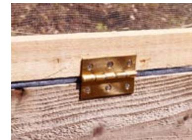
Posizionare la copertura sull'aiuola rialzata. I paletti angolari dell'aiuola possono aiutare a tenere allineata la copertura. Le cerniere vanno sul lato opposto rispetto a quello con le corde. Fissare una cerniera nel mezzo e una a 30 cm da ciascuna estremità della copertura e della base.
