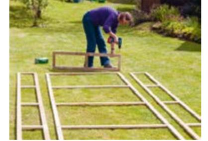
Assemblare tutti e cinque gli elementi fissando le viti da 5 mm per 100 mm nei fori passante. Una volta completati, il tetto misurerà 366 cm x 122 cm, i due fianchi 366 cm x 31 cm e le due teste 117 cm x 31 cm.
