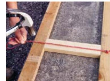
Nel fissarla, tendere la rete in modo tale da non lasciare pieghe ma non al punto da lacerarsi nei punti di fissaggio. Fissare i tre pezzi di corda equidistanti su un fianco. Col martello incassare le cambrette per bloccare la corda (v. immagine).
