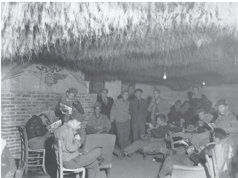
20. Il posto di ristoro del 62nd Troop Carrier Squadron. Interessante il controsoffitto isolante rudimentale composto da lana e rafia. (Courtesy Lars Eklund's family)
